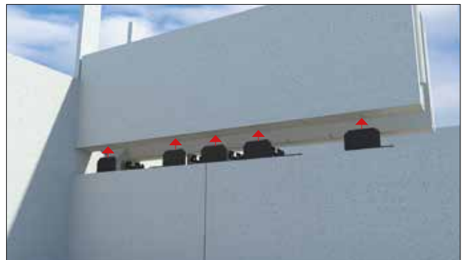
45 Après la coupe des 2 cm les planelles retrouvent le pas de 12,5cm.
