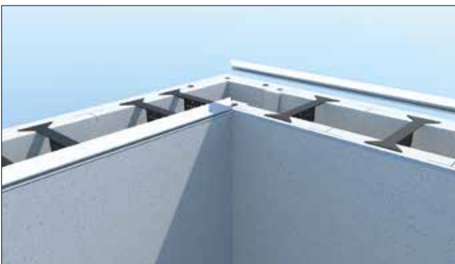
54 Pose des rails d'accrochage du liner suite
